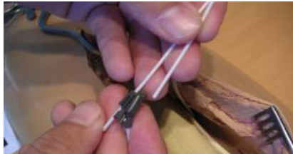
C. Die Kabelenden durch die Metallklemme führen.
